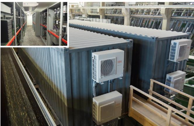
Holz Hahn entschied sich bei der Elektroinstallation für ein vorinstalliertes Plug-in-System mit einem klimatisierten Schaltschrankraum-Konzept in Containerbauweise
